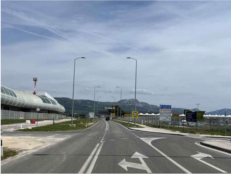
5.17 Postojeće stanje - prilaz Zračnoj luci sa zapadne strane
